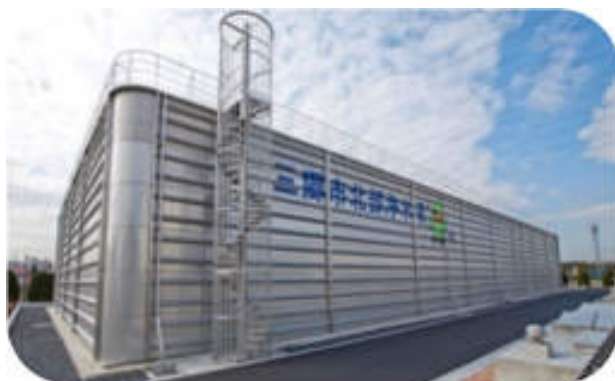
北部浄水場(耐震性ステンレス製配水池)
