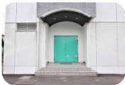
防水扉(北部第二配水場)
