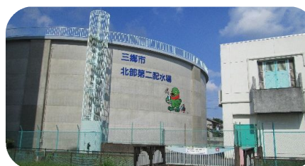
北部第二配水場
