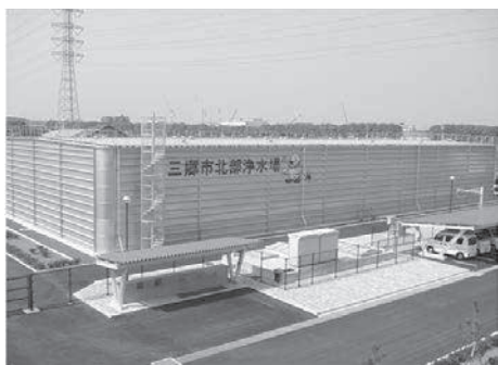
国内最大級ステンレス製配水池
