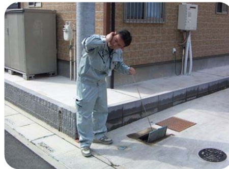
図 5-12.漏水調査（戸別音聴）
