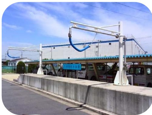
図 5-7 .災害時給水装置（北部浄水場）
