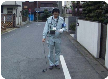
図 5-11.漏水調査（路面音聴）
