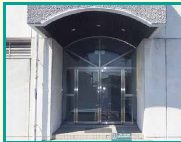
防水扉設置前
