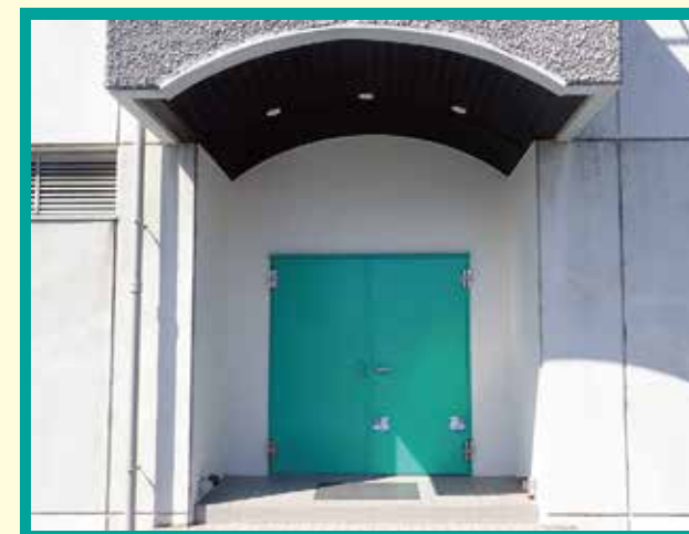
防水扉設置後
