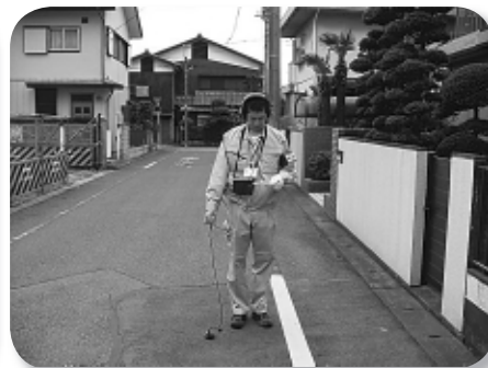
音聴漏水調査
