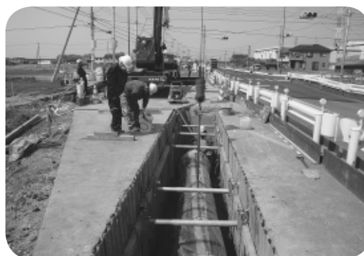
配水管布設替工事
