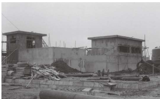
昭和42年頃 建設中の中央浄水場の写真
