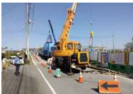
写真) 平成30年 三郷放水路地下に埋設した水道管の布設替工事。
