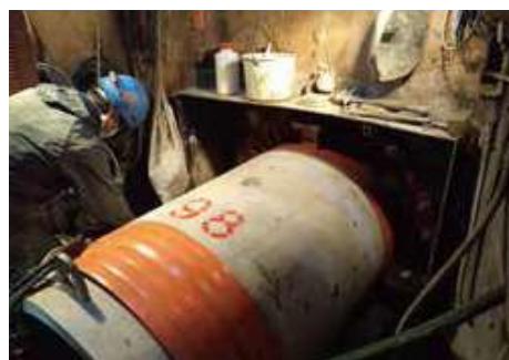
写真) 平成30年 三郷放水路地下に埋設した水道管の布設替工事。
