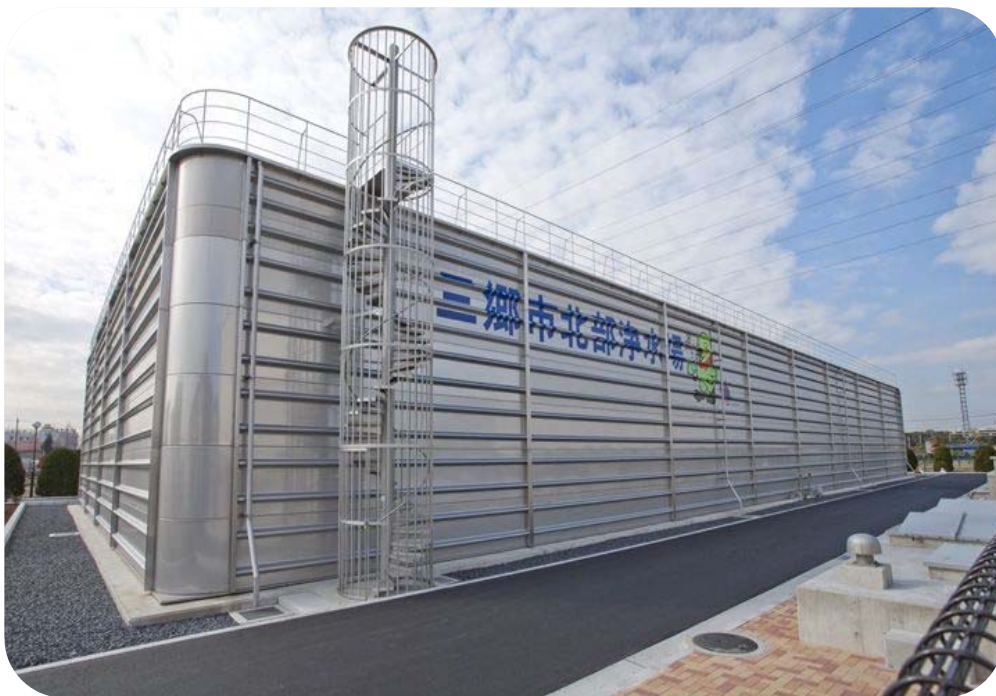
図 3-11.北部浄水場耐震性ステンレス配水池
