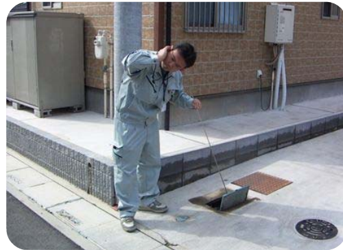
図 5-12.漏水調査（戸別音聴）
