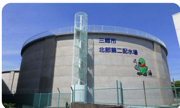
図 3-8.北部第二配水場配水池
