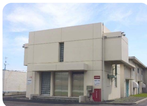
図 3-9.中央浄水場 自家発電電気室
