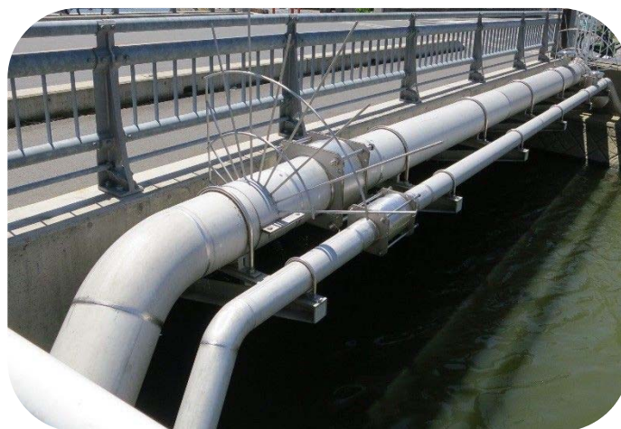
図 3-10.橋梁添架管（寄巻橋）
