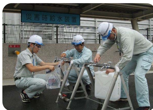
図 3-13. 災害時用応急給水栓
