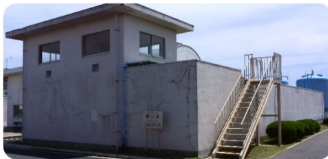
着水井・塩素混和池
