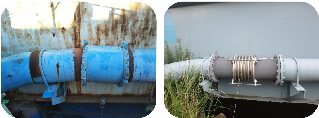
北側道橋添架管(左:補修前、右:補修後)
