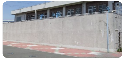
中継ポンプ井
