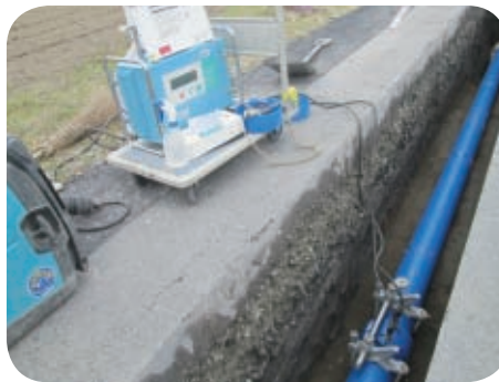
ポリエチレン管の融着作業
