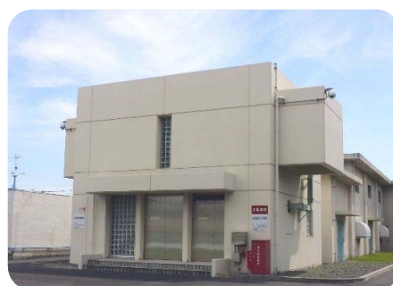
図 3-9.中央浄水場 自家発電電気室
