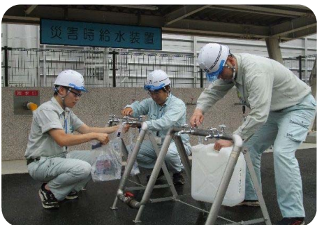
図 3-13. 災害時用応急給水栓
