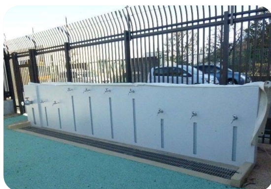
図 3-15.東京都水道局 三郷浄水場内の応急給水区画
