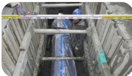
基幹管路更新工事の様子
