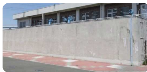
中継ポンプ井
