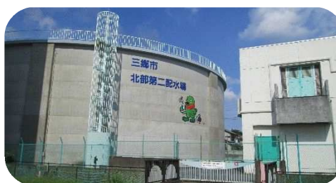
北部第二配水場
