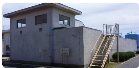
着水井・塩素混和池
