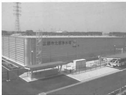
国内最大級ステンレス製配水池
