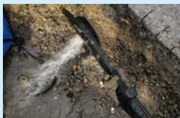
老朽化した水道管から水が漏れる様子
