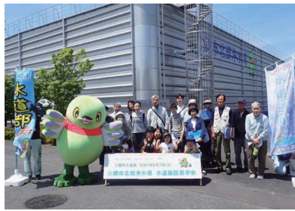
▲北部浄水場ステンレス製配水池前にて
