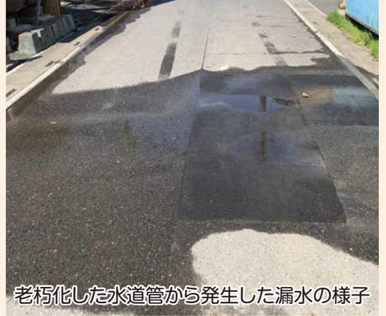
老朽化した水道管から発生した漏水の様子
