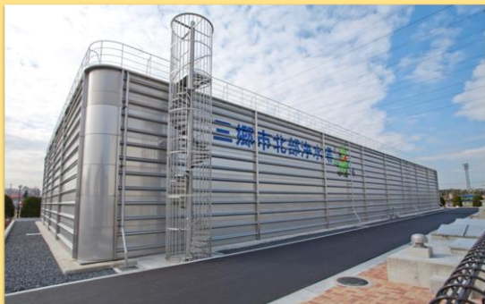
北部浄水場 ステンレス製配水池
