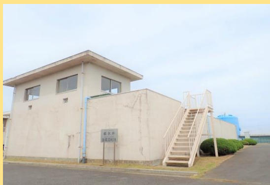
北部浄水場 着水井・塩素混和池
