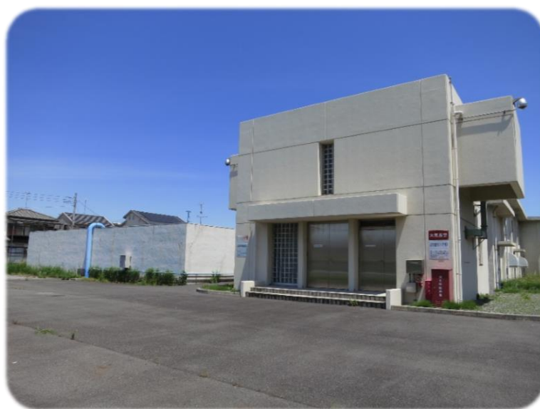
中央浄水場 RC 配水池・自家発電電気室
