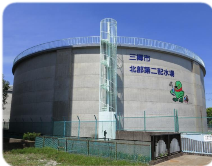
北部第二配水場 P C 配水池
