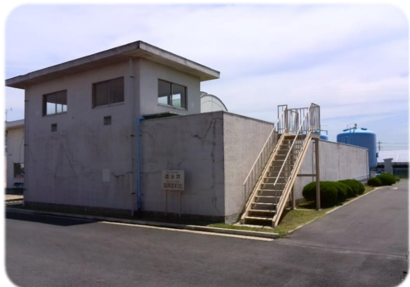
北部浄水場 着水井・塩素混和池
