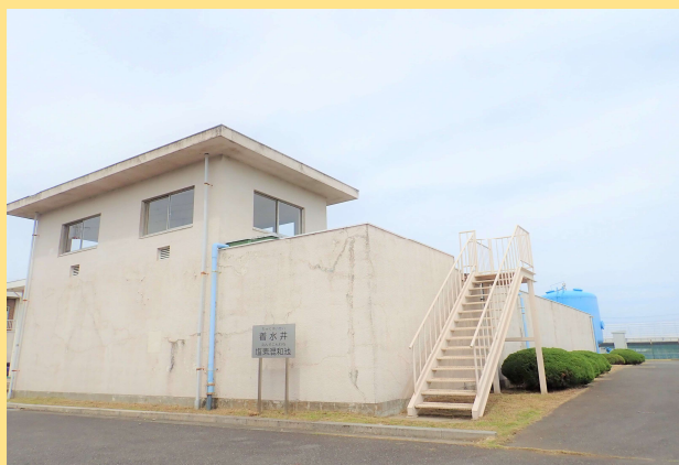
北部浄水場 着水井・塩素混和池
