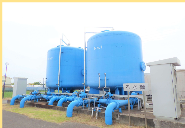
北部浄水場 ろ水機
