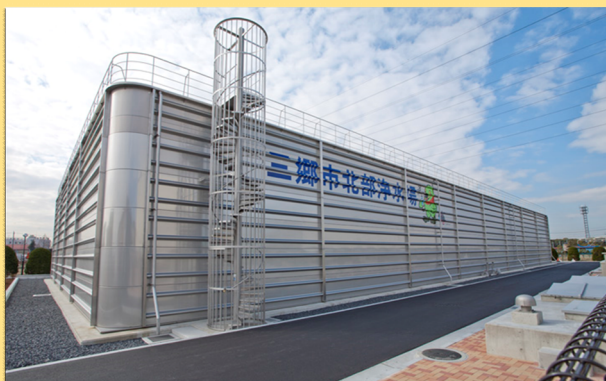
北部浄水場 ステンレス製配水池
