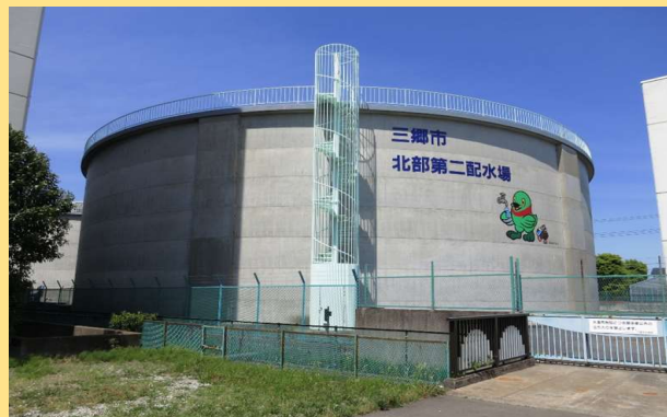
北部第二配水場 PC配水池
