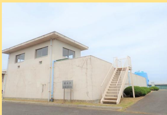
北部浄水場 着水井・塩素混和池
