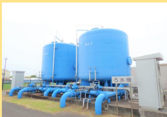
北部浄水場 ろ水機
