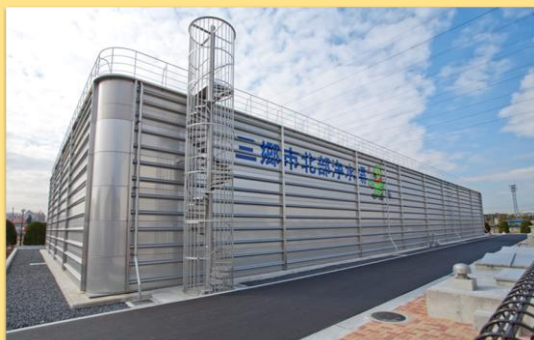
北部浄水場 ステンレス製配水池
