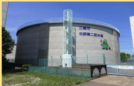
北部第二配水場 PC配水池
