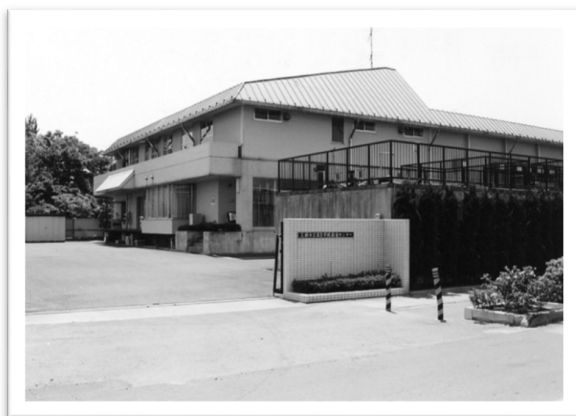
鷹野学校給食センター東館 (昭和 63 年 4 月供給開始)
