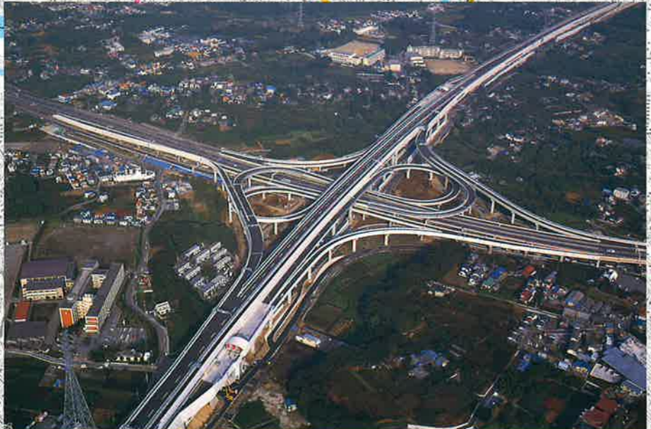
川口ジャンクションは、4層構造のセミクローバー式で、外かんの自動車専用部、東北自動車道、首都高速道路葛飾・川口線を相互に連絡します。
