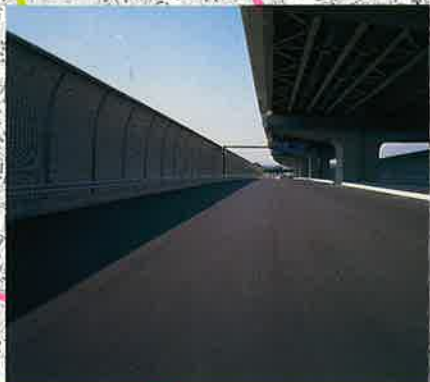
遮音壁は騒音の軽減をはかるばかりでなく、色彩や形を凝らし、景観への配慮をしています。
