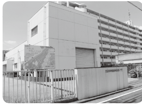
早稲田中継ポンプ場
