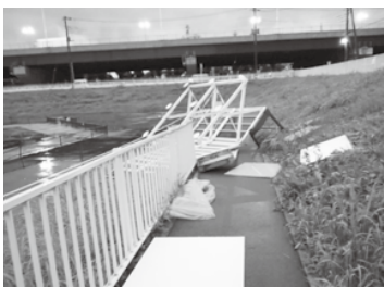
竜巻被害を受けた陸上競技場公園
