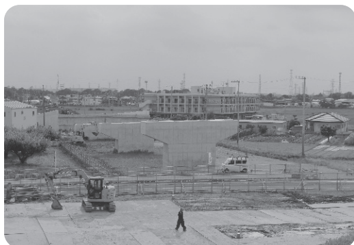
整備が進む仮称三郷流山橋と周辺道路
