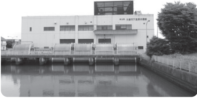
大場川下流排水機場
