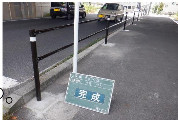
車両交通量の多い道路に設置されている歩道で、車両の侵入防止を目的とした横断防止柵の設置を実施しました。
