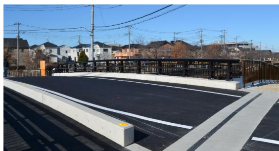
橋の架け替え 和泉橋(令和4年度)
