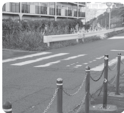
江戸川堤防下の道路
