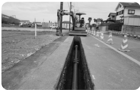
耐震性に優れている ポリエチレン管布設の様子
