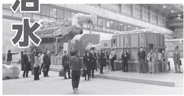
三郷排水機場の大型排水ポンプ設備
