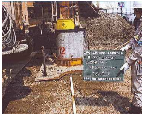
OPHC杭施工状況 (φ1000)
