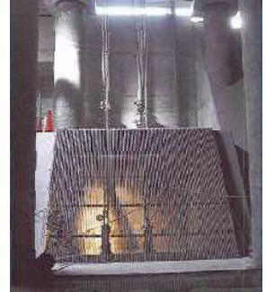
○調整池内部：PC壁体、PHC杭、PCスラブ
