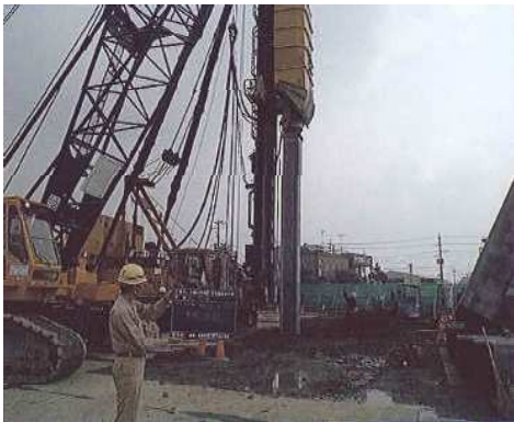
OPC壁体施工状況 (口700×700)
