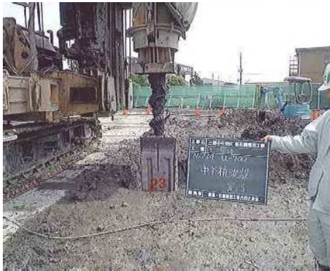
OPC壁体施工状況 (オースクリュー)
