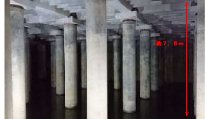
○調整池内部：PC壁体、PHC杭、PCスラブ
