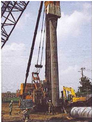
OPHC杭施工状況 (φ1000)
