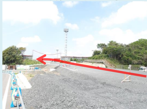
上り線入口施工状況 【東日本高速道路㈱施工】
