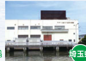
大場川下流排水機場
