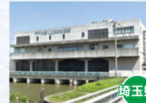
大場川上流排水機場
