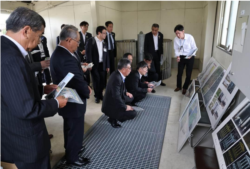
視察の様子(新和調整池 (みさと地下神殿))
