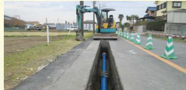
老朽化した水道管の布設替えを順次行っていますが、工事には道路の掘削等も伴うため、多額の費用がかかります。
