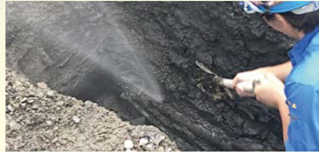
老朽化した水道管から水が漏れる様子
