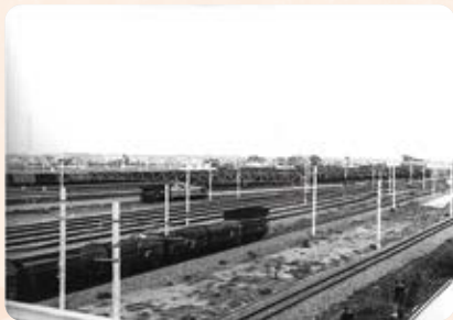
操業中の武蔵野操車場(昭和50年ごろ)
