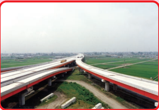
▲建設中の三郷ジャンクション (昭和59年7月)
