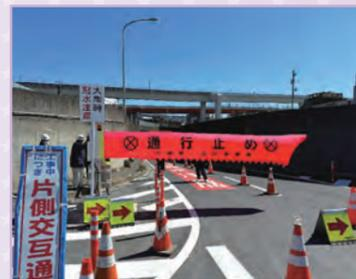
エア遮断機は、冠水時などに、遠隔操作で迅速に道路を封鎖するための装置です
