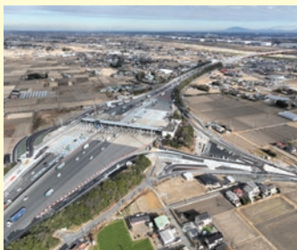
▲三郷料金所スマートインターチェンジ
