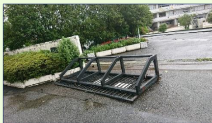
竜巻により小学校の正門が横倒しになった様子
