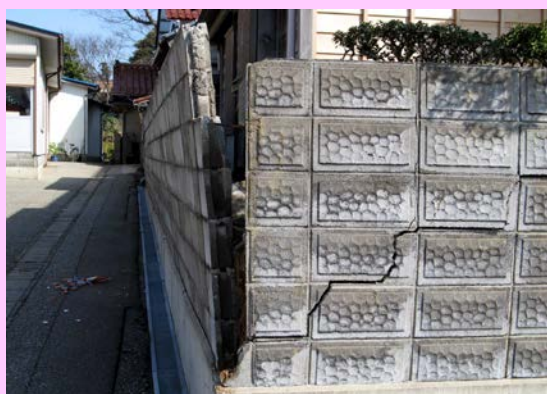
写真出典：(一財)消防防災科学センター
