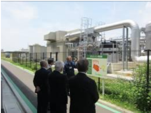
●ガスエンジン発電機（1Mkwhを発電）
